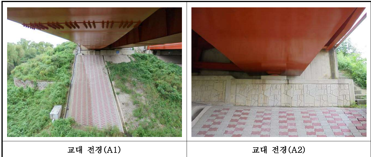
【사진 2.3.8】 교대 전경
