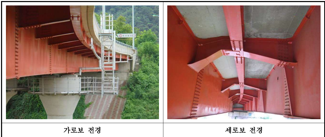
【사진 2.3.6】 가로보 및 세로보 전경
