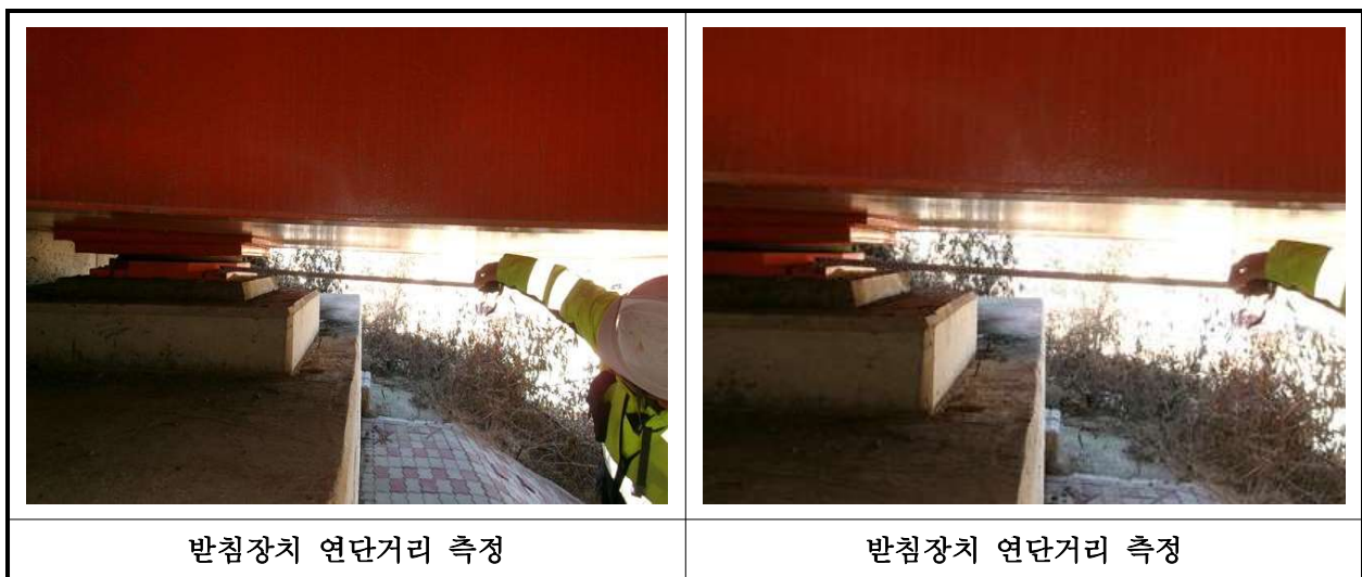
【사진 2.3.14】 교량받침장치 연단거리측정
