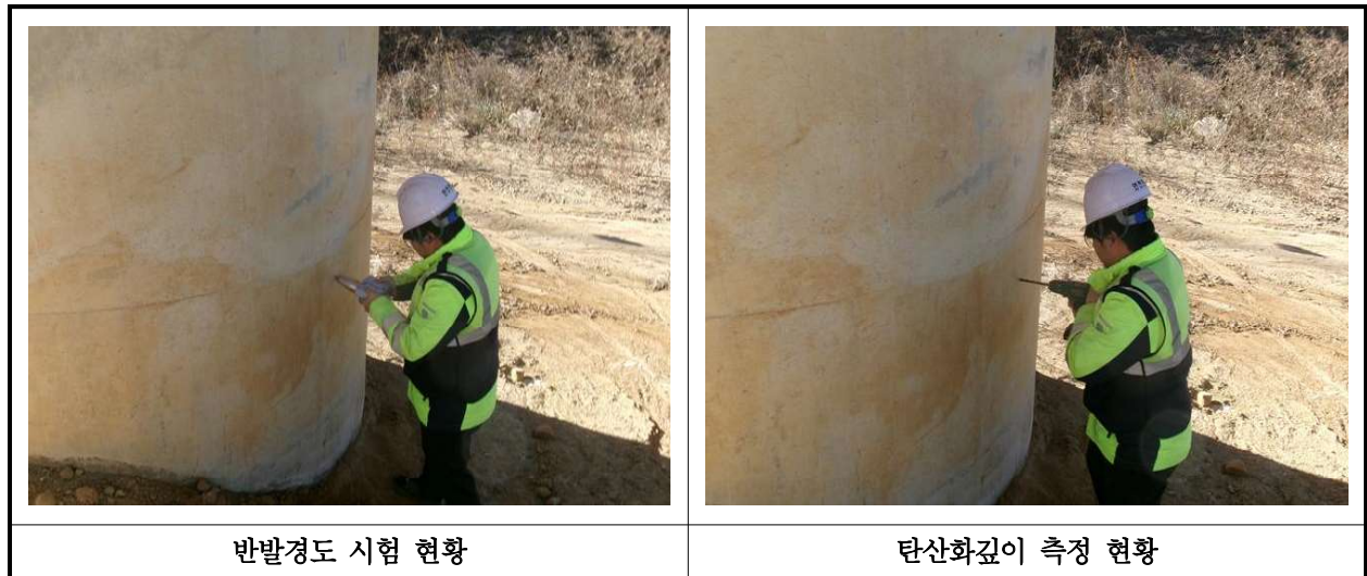
【사진 2.4.1】 콘크리트 내구성조사 현황
