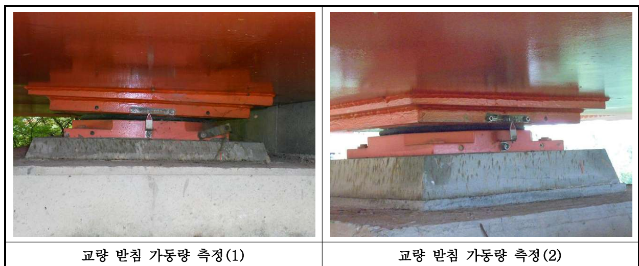
【사진 2.3.15】교량받침 이동량 측정
