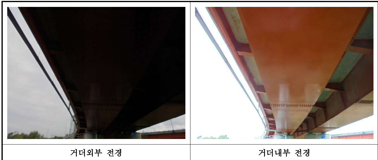
【사진 2.3.4】 거더 전경
