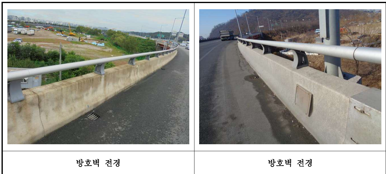
【사진 2.3.23】 방호벽 및 중앙분리대 전경
