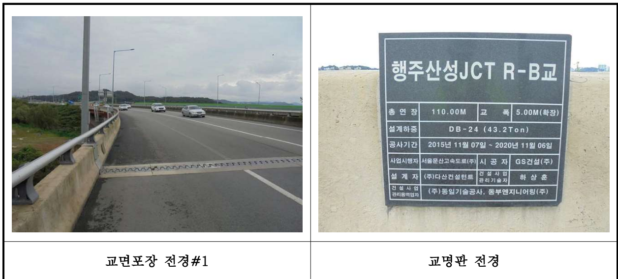
【사진 2.3.19】 교면포장 전경
