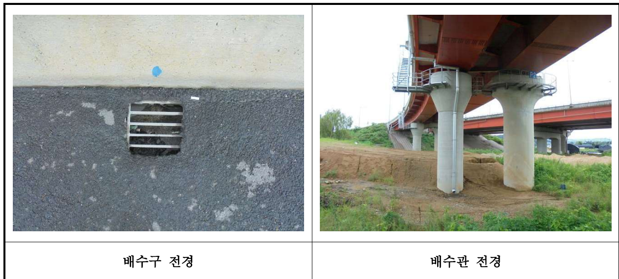
【사진 2.3.21】 배수시설 전경
