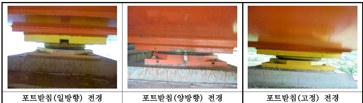
【사진 2.3.12】 교량받침 전경
